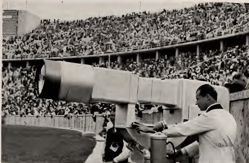
Wie das Geschützrohr einer Riesenkanone mutet das Aufnahmegerät für das Fernsehen an.
